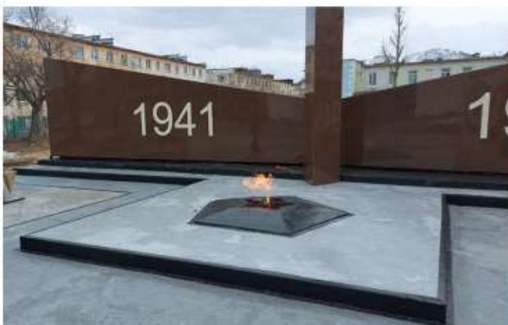
Стеклопластиковый кожух надевается поверх железобетонной основы памятника
