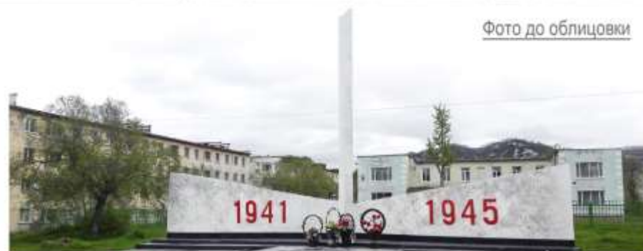
Стеклопластиковый кожух надевается поверх железобетонной основы памятника
